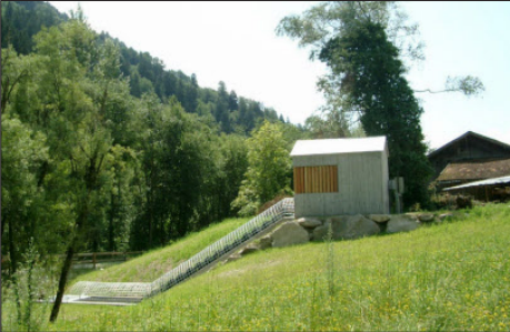
Kraftwerk Weger im Passeiertal, Arch. Thomas Wiedmer Ursula Gasser
